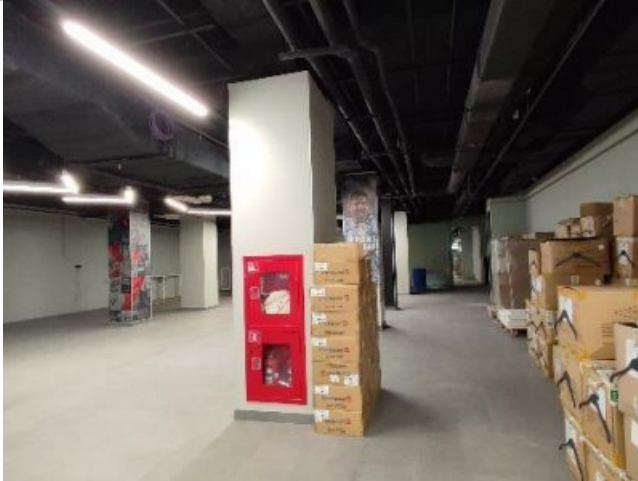
Фото 103. Внутреннее помещение 2го этажа.
