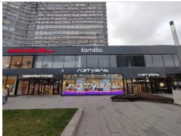
Фотография 3.2. Внешний вид здания
