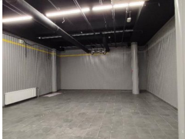
Фото 108. Внутреннее помещение 2го этажа.
