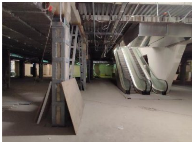
Фото 145. Внутреннее помещение -2го этажа.
